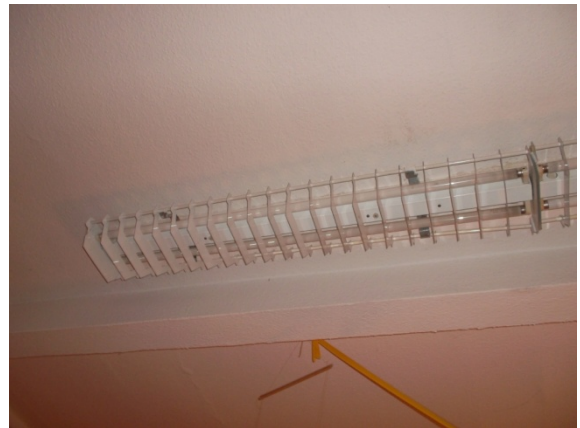
Ineffiziente T8-Leuchtstofflampen
