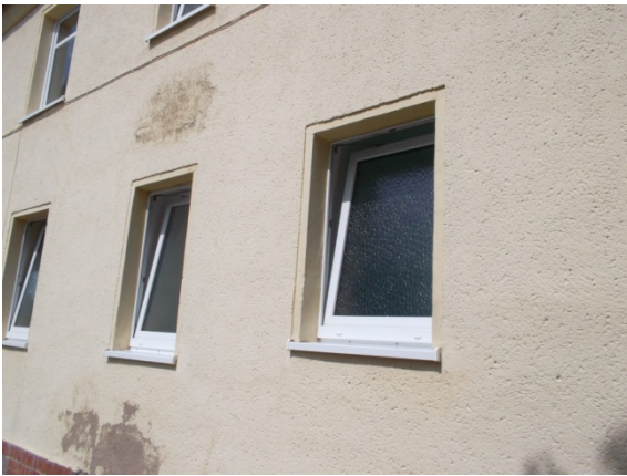
keine Dämmung der Fassade; Wärmeschutzverglasung
