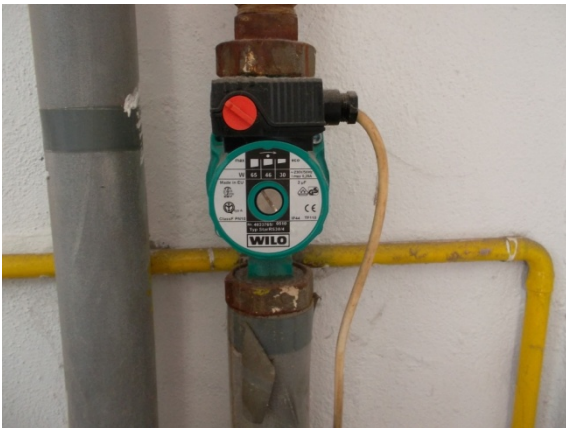
Umwälzpumpe, dreistufig 30...65 W, keine zeitliche Programmierung (orientiert an Bedarf)
